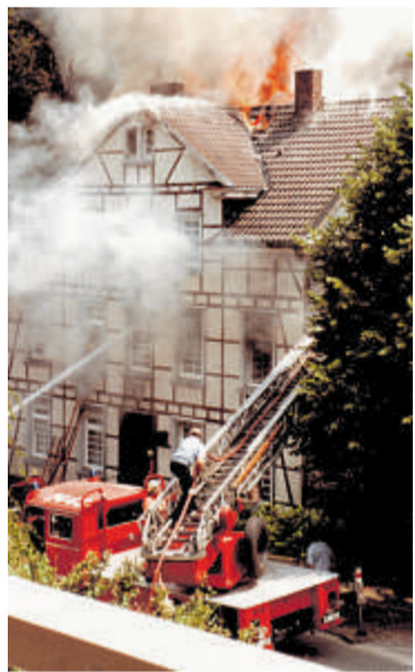
Bei dem Brand 1982 wurde das Fachwerkhaus völlig zerstört. REPRO: GUROR
